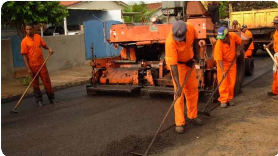
Pavimentação asfáltica em Rosana-SP.
