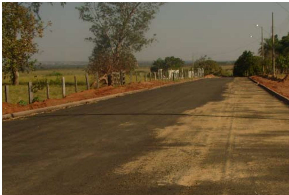
Asfalto de qualidade para o Município de Rosana-SP.
