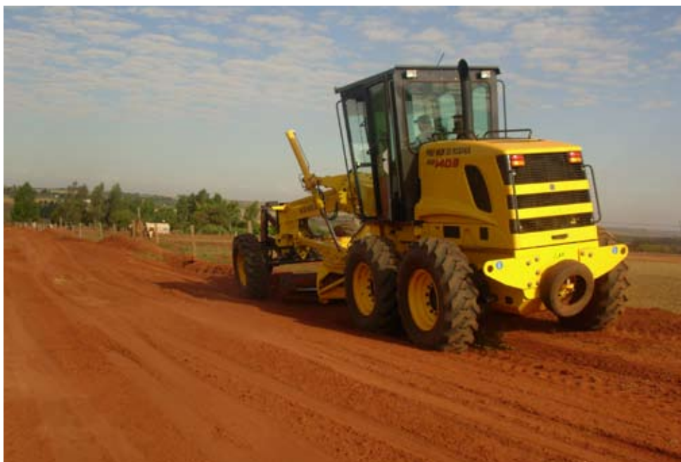
Melhoria das estradas dos assentamentos da Gleba XV de Novembro.
