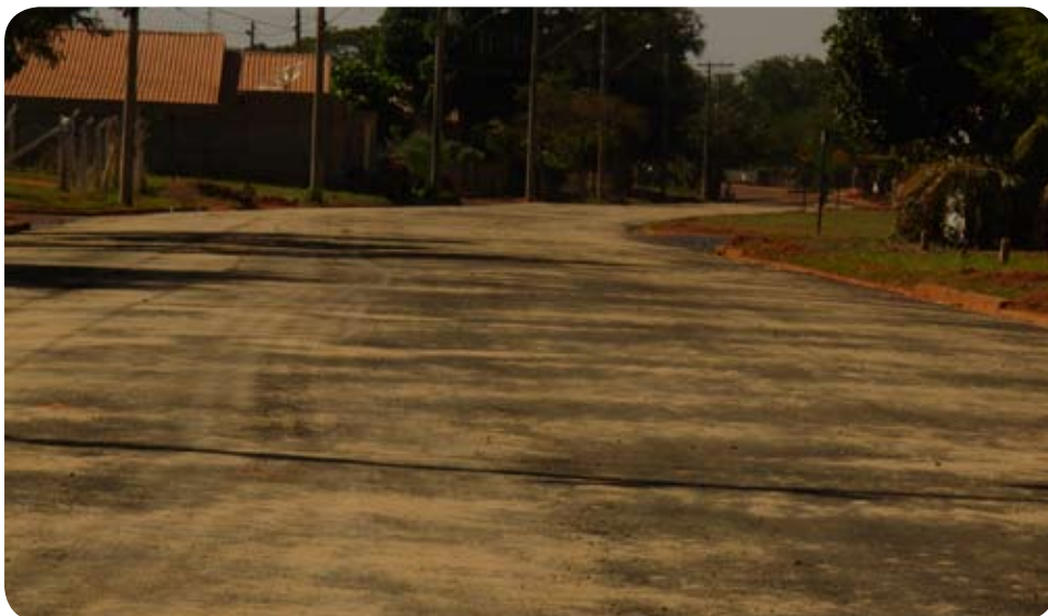
Pavimentação asfáltica na cidade de Primavera-SP.
