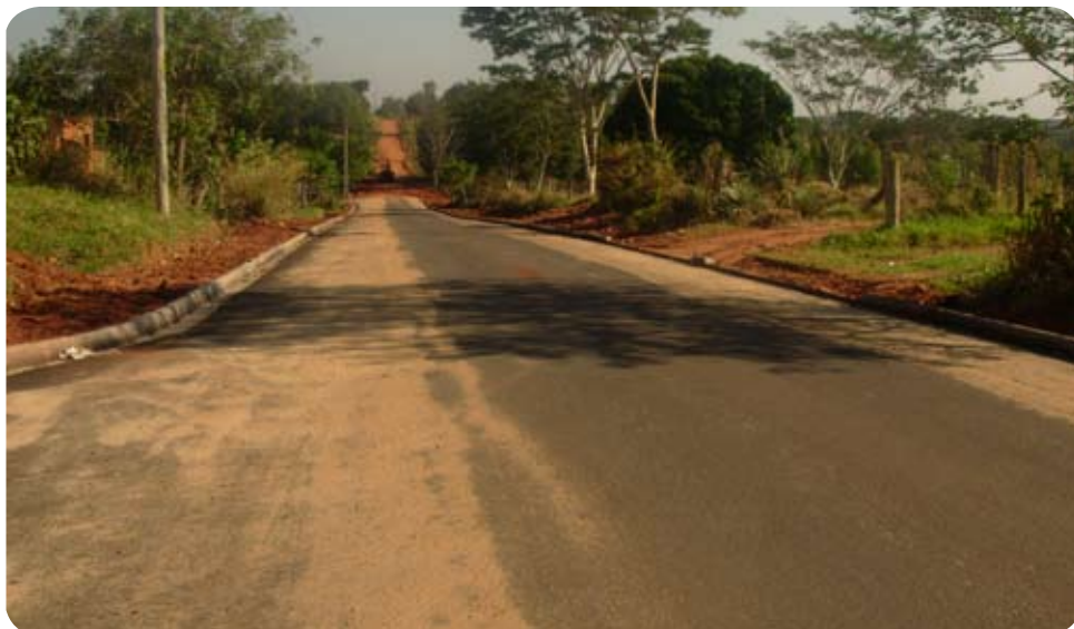
Pavimentação asfáltica na estrada do Pontalzinho em Rosana-SP.
